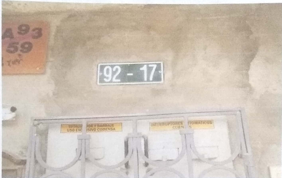
POR EL NORTE CON EL PREDIO DE PLACA 92-17 CASA (DOS)
