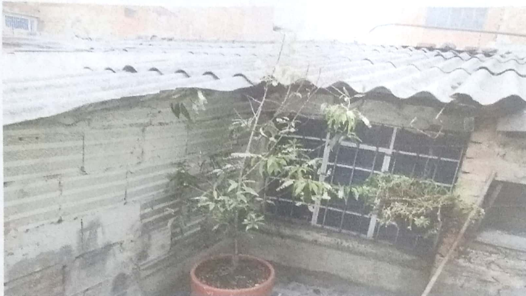
VENTANA DEL APARTAMENTO Y HALL QUE SEPARA LOS LOCALES.
