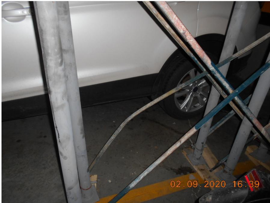
Figura 10. Cruceas dobladas por hundimiento progresivo del terreno
