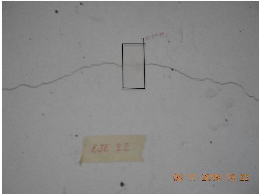
Figura 12. Revisión de la actividad de las fisuras mediante marcas de yeso
