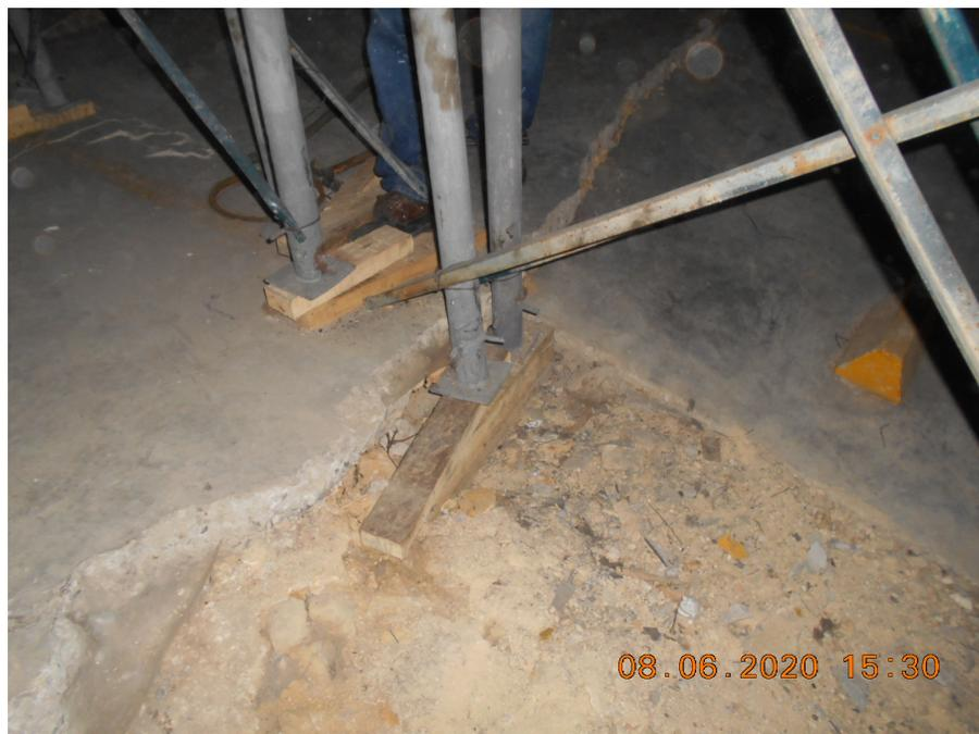
Figura 7. Colocación de suplementos adicionales
