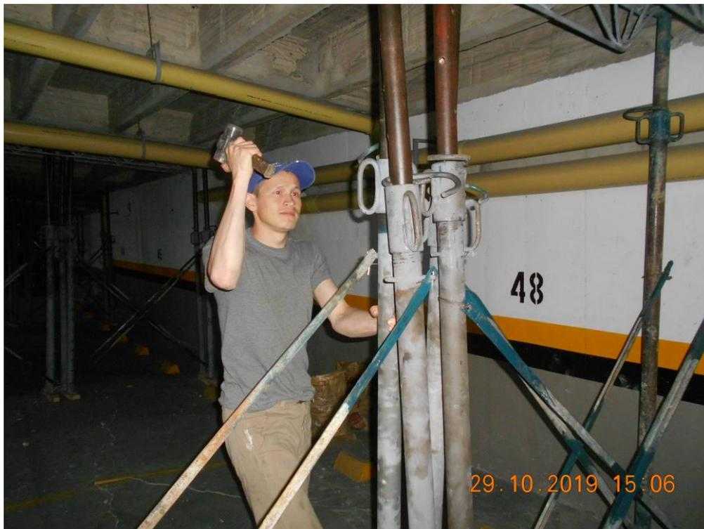
Figura 1. Ajuste de parales al inicio del seguimiento.
