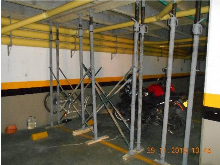
Figura 4. Instalación de apuntalamiento en nuevos ejes, utilizando tablón de madera
