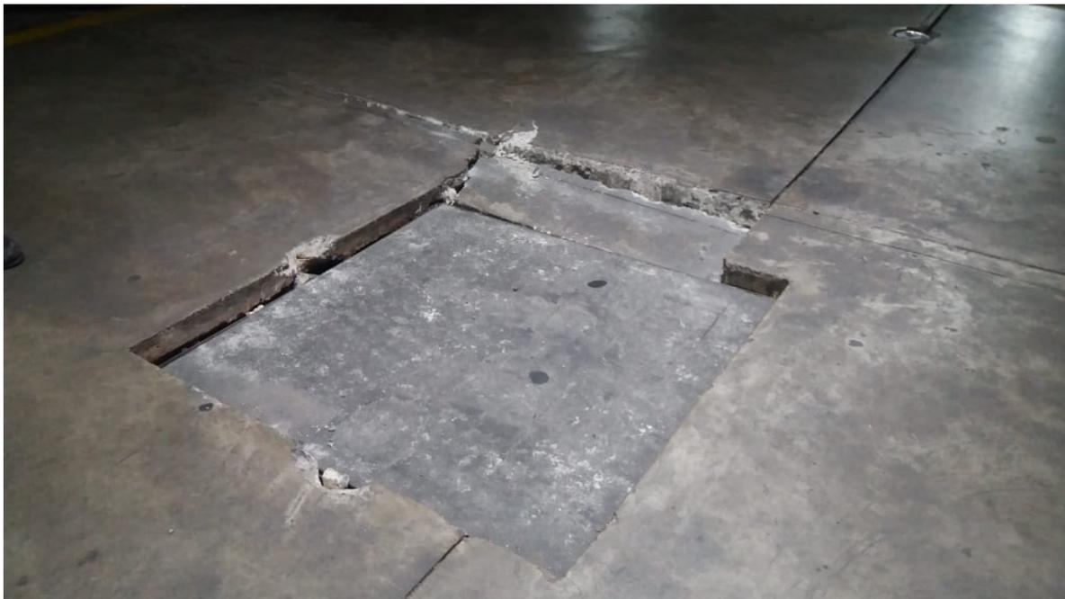
Figura 55. Hundimiento de caja de instalaciones
