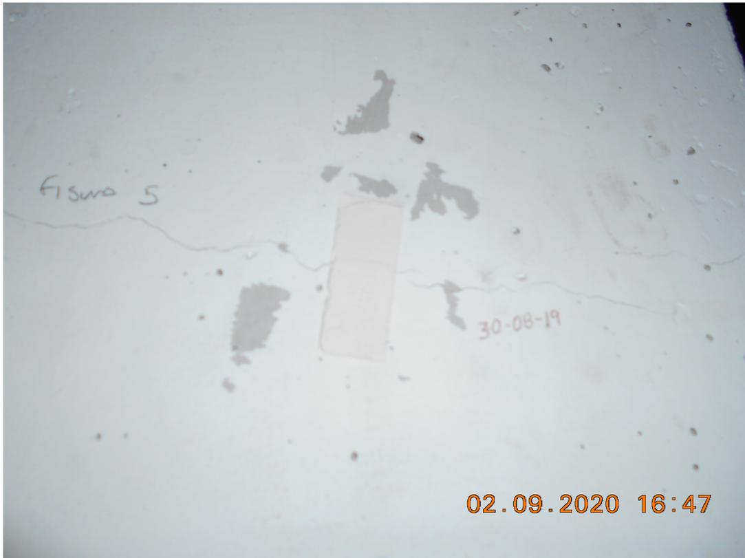
Figura 18. Revisión marcas de yeso, se observan fracturadas
