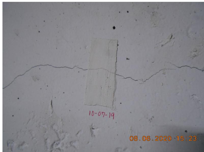
Figura 49. Marcas de yeso fracturadas demuestran que la estructura está en movimiento
