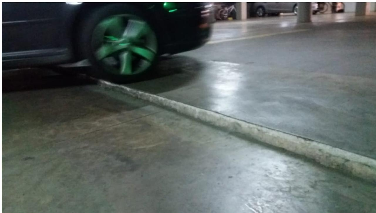
Figura 61. Placa de contrapiso levantada con diferencial de asentamientos
