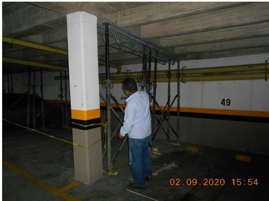
Figura 9. Verificación y ajuste de parales
