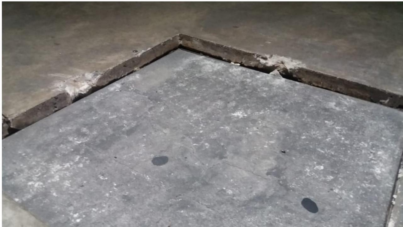
Figura 56. Hundimiento de caja de instalaciones
