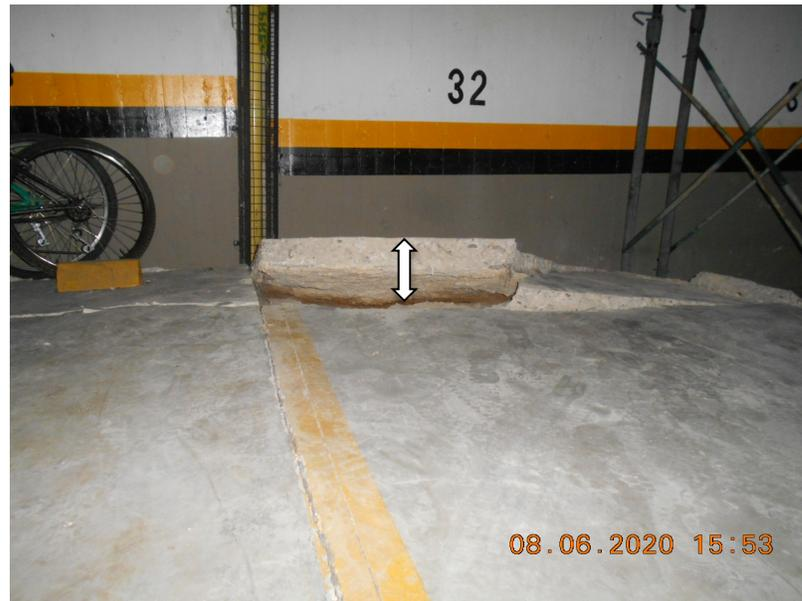
Figura 54. Placa de contrapiso levantada
