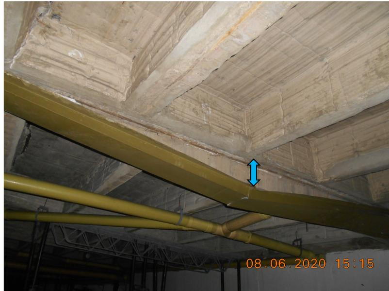
Figura 52. Cambio de nivel entre plataformas en zona de junta
