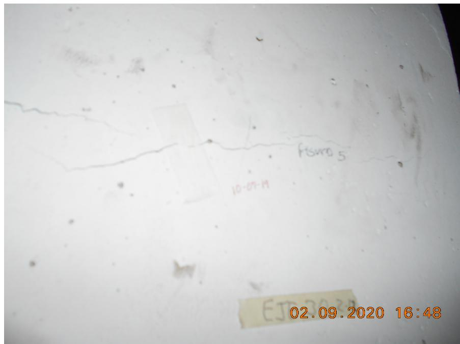
Figura 17. Revisión marcas de yeso, se observan fracturadas
