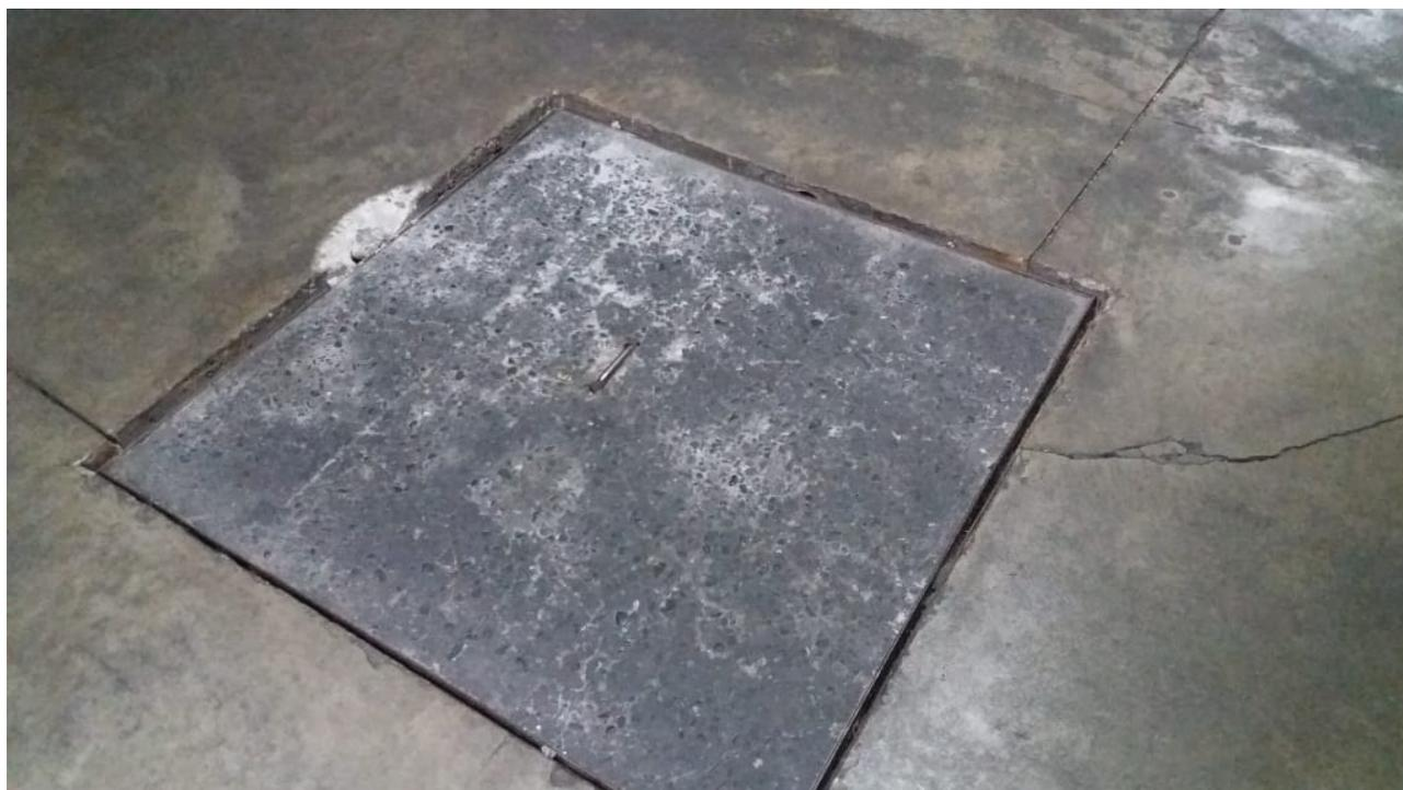
Figura 59. Placa de contrapiso agrietada alrededor de caja de instalaciones hundida
