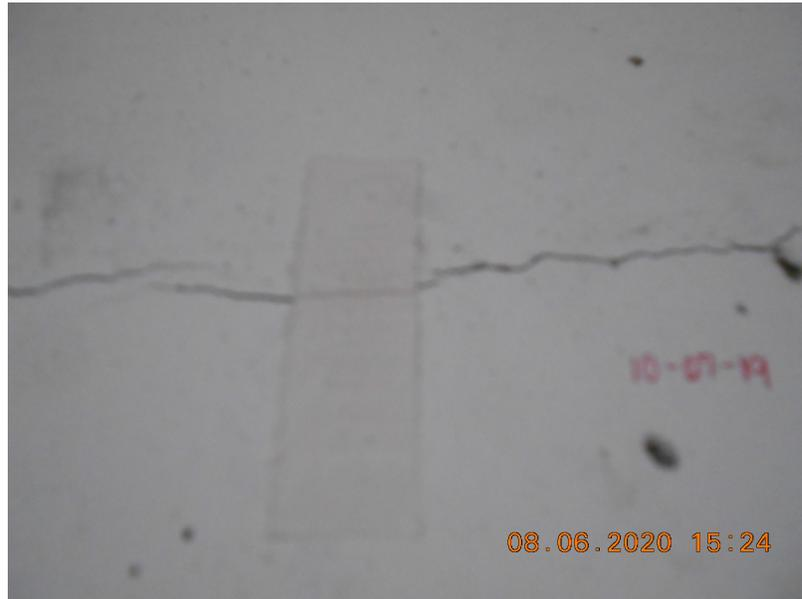
Figura 50. Marcas de yeso fracturadas demuestran que la estructura está en movimiento
