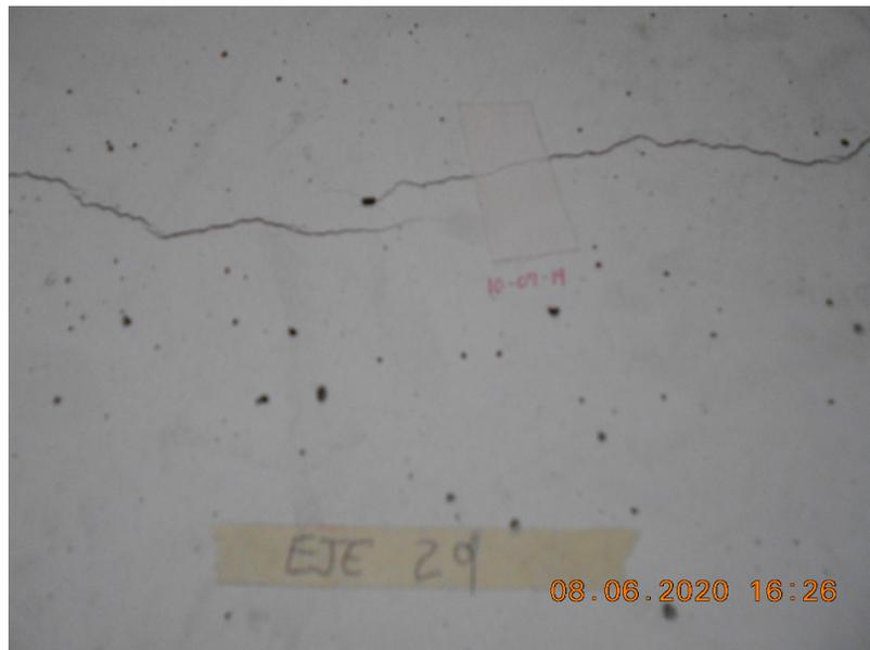
Figura 51. Marcas de yeso fracturadas demuestran que la estructura está en movimiento
