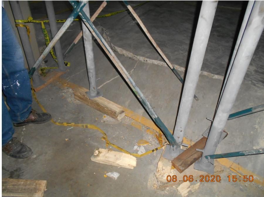
Figura 6. Instalación de suplementos adicionales
