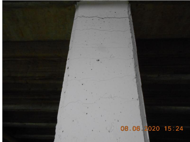
Figura 48. Nuevas fisuras sobre cara de columnas
