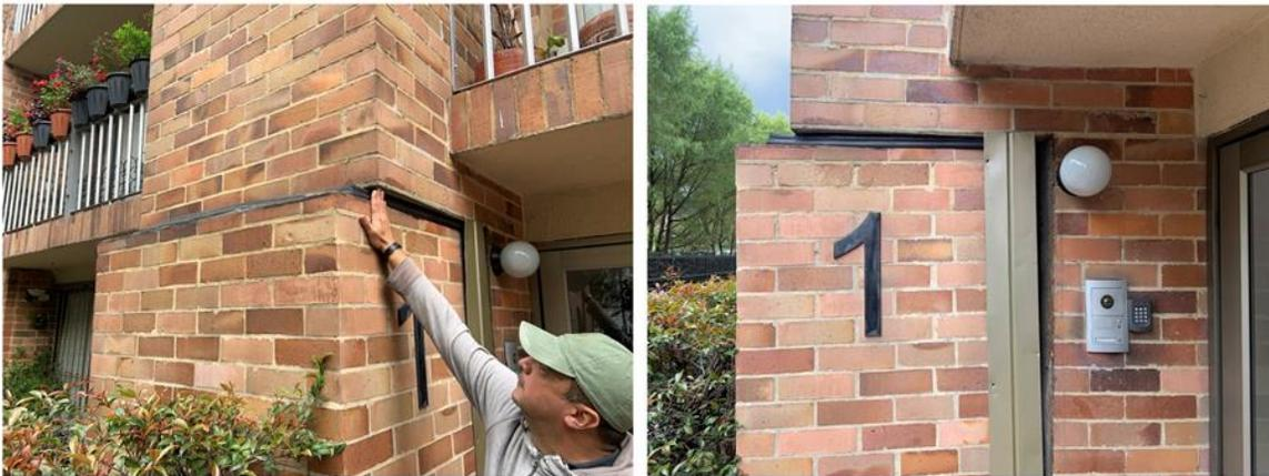
**Foto 2. Estado de los movimientos del cerramiento en mampostería anexo a la Torre 1 en noviembre de 2019. Se aprecia asentamiento del orden de 3 cm y desplazamiento lateral del orden de 15 cm.**
