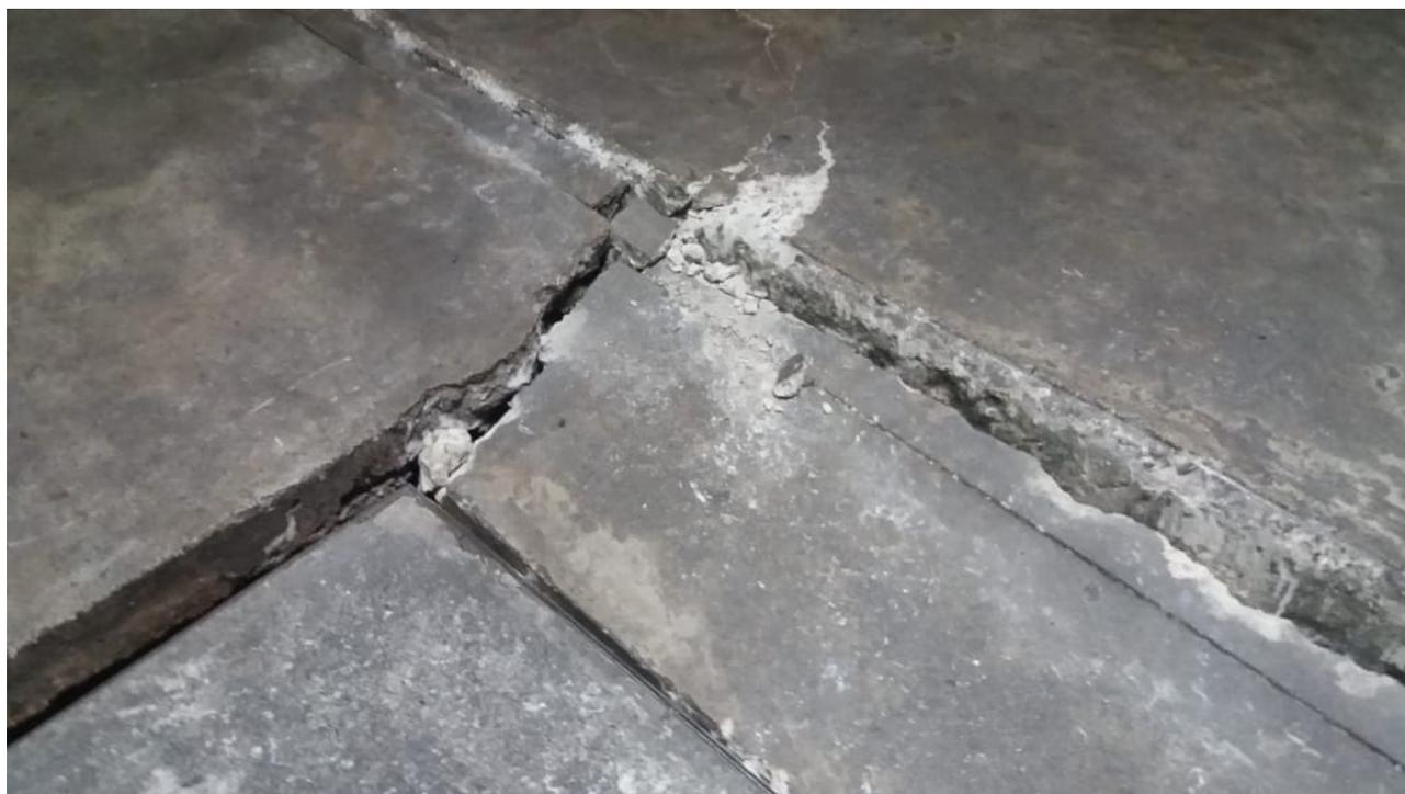
Figura 57. Hundimiento de caja de instalaciones
