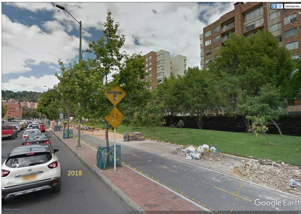
Figura 6. Condiciones a lo largo del costado sur del proyecto en 2018 (Google Earth Street view). Se aprecian daños en la ciclo ruta y los adoquines aledaños.
