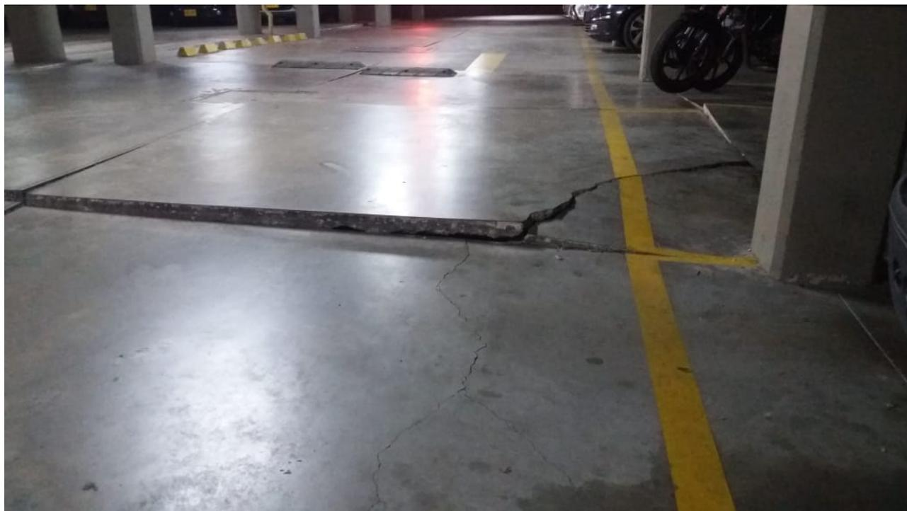
Figura 58. Placa de contrapiso levantada
