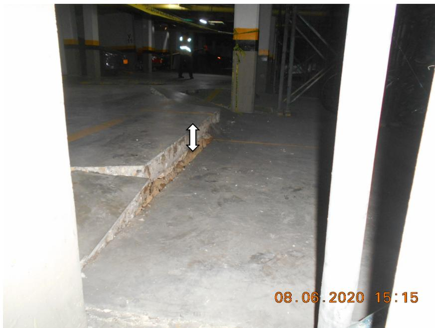
Figura 53. Hundimiento de placa de contrapiso
