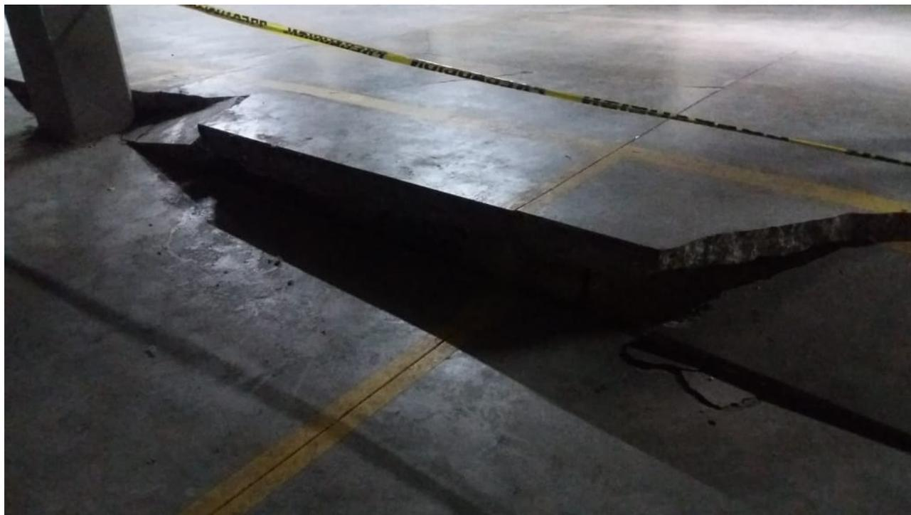
Figura 60. Placa de contrapiso levantada
