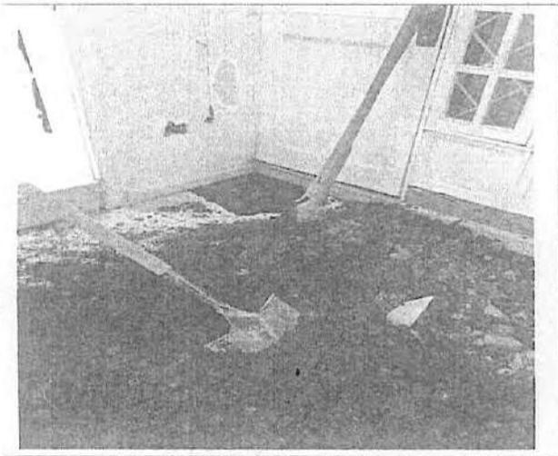
Excavacion para determinar el tipo de cimentación, se demuele la placa de contra piso, se encuentra una base de recebo de 20 cm donde se apoya la
