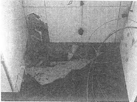
FOTO 9 Deterioro de la instalación sanitaria
