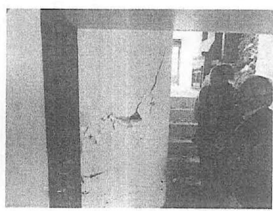
FOTO 2 Este muro puede reemplazarse; es muy pequeño y soporta carga mínima
