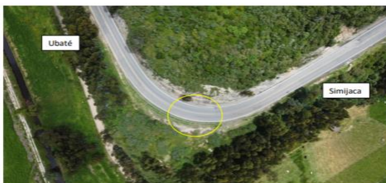
FOTOGRAFIA 01 - Panorámica: Se aprecian las características del lugar del accidente de tránsito, el cual corresponde a la vía Ubaté – Simijaca, kilómetro 20+930 metros; corresponde a una vía curva, con una calzada de dos carriles en material asfalto, en doble sentido de circulación. La vía tiene peralte de 2°, y pendiente en ascenso en sentido Ubaté – Simijaca, de 2 %. Respecto a la demarcación, se observa doble línea amarilla continua, línea blanca de borde de vía.
