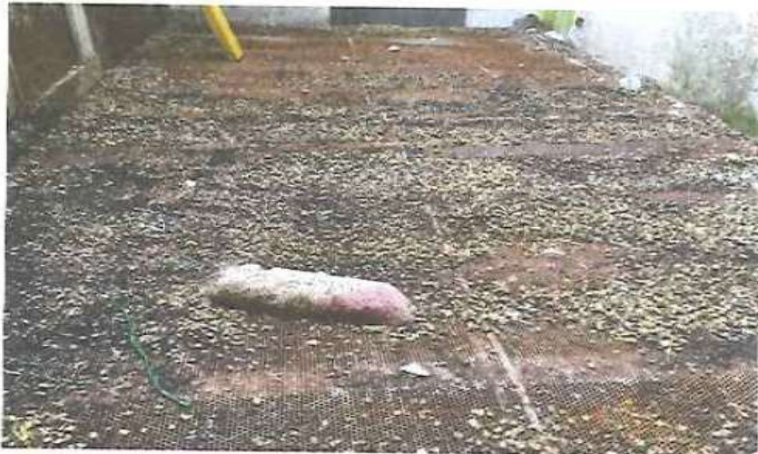
MALLAS DE SECADO EN AVANZADO ESTADO DE CORROSION
