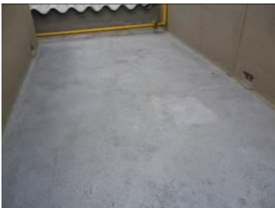
Costado norte del vacío torre 3. Especialmente en la media caña se observa demasiada rugosidad en la superficie sobre la cual se aplicó la impermeabilización.
