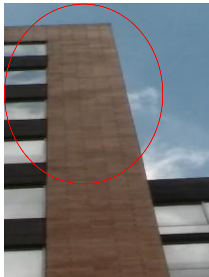
Fachada en ladrillo ubicada al costado oriental de la fachada principal torre 1. Meteorización acelerada y media.
