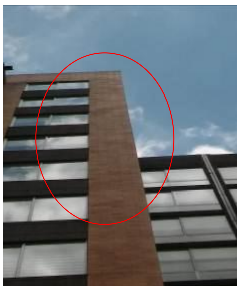
Fachada en ladrillo ubicada al costado oriental de la fachada principal torre 1. Meteorización acelerada y media.
