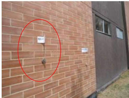
Detalle de muestra 1 mortero fachada lateral torre 3
