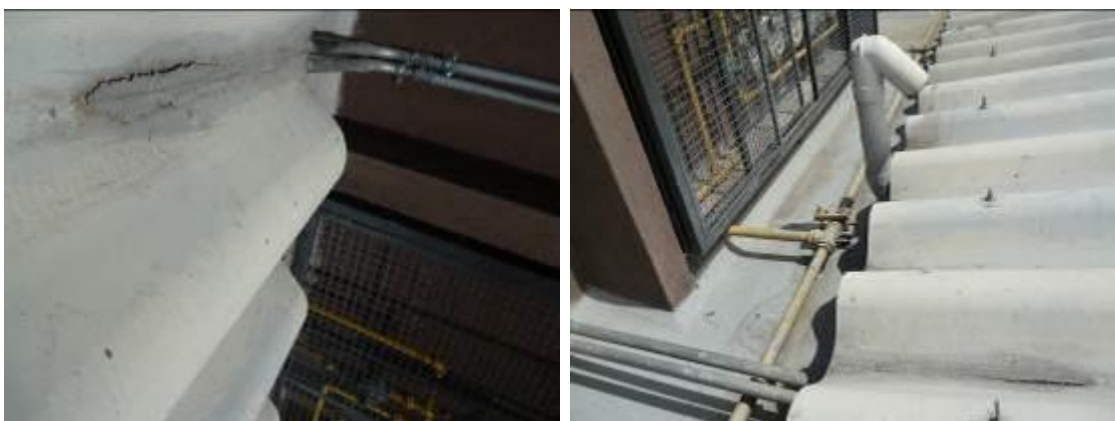
Vacío oriente. Reparaciones de tejas frente al vacío ya deterioradas; en el corto plazo la fisura quedará expuesta trayendo consigo filtraciones de agua.
