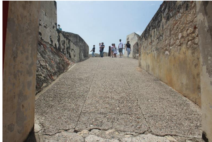
Rampa de acceso 7, vista desde la cota mas baja.
