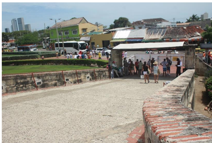
Empalme entre rampas 1 o cota de inicio al Castillo, tomada desde el final de la uno e inicio de la rampa 2.
