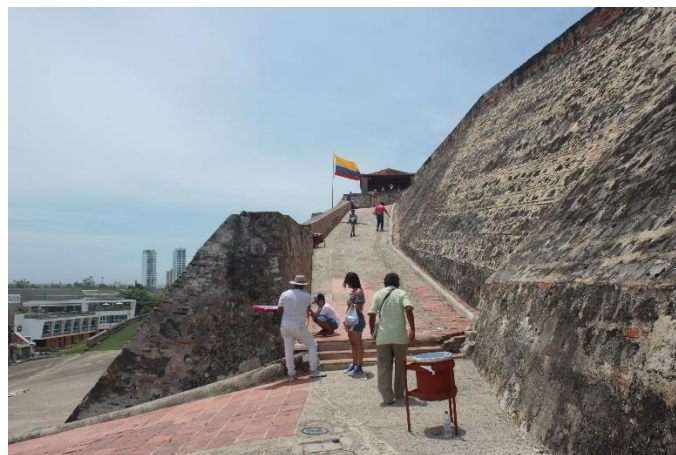
Inicio de la rampa de acceso 4, con tres escalones, elementos que obstruyen la accesibilidad de personas con discapacidad física
