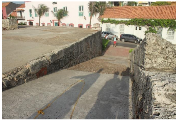
Rampa de acceso al Baluarte de Santa Cruz
