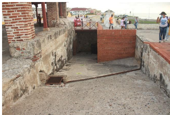
Segunda rampa de acceso al edificio militar las Bóvedas, comunicación interna
