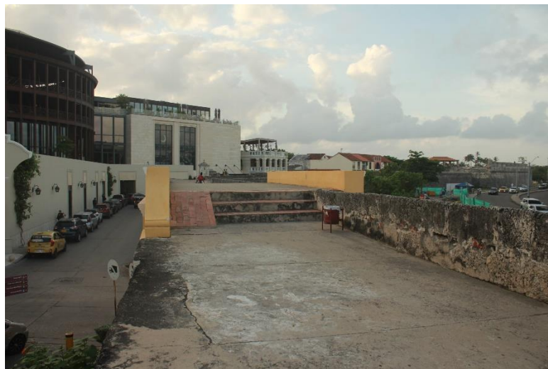
Escaleras en la cortina de murallas frente la antigua plaza de toros
