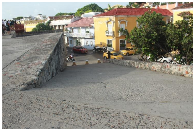
Rampa acceso Baluarte de Santiago Apóstol
