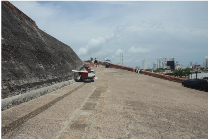
Rampa de acceso 3
