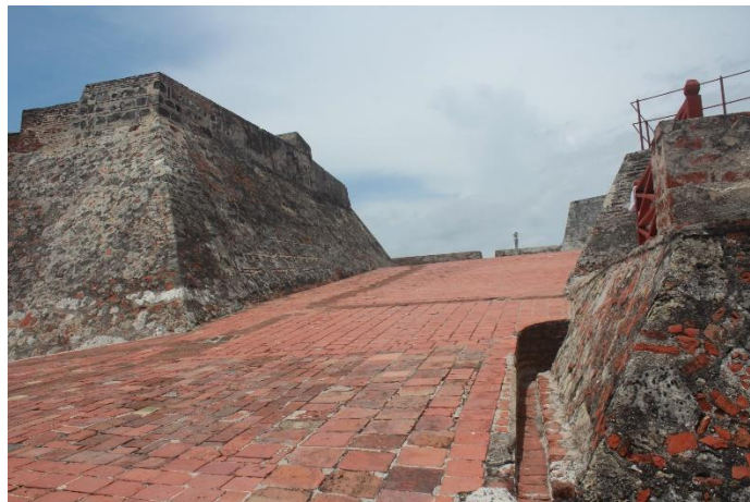
Rampa de acceso 5
