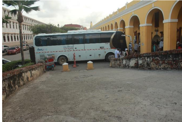
Rampa de acceso lado Norte edificio militar las Bóvedas tramo recto.
