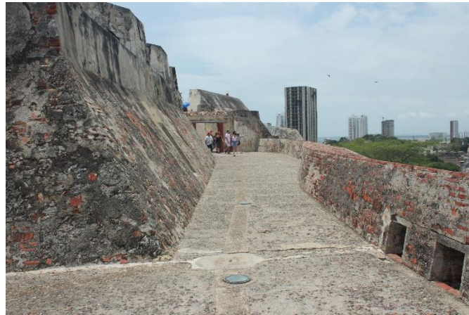
Rampa de acceso 6
