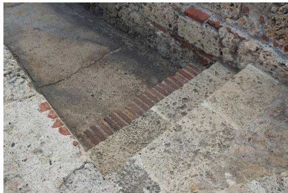
Peldaños entre las cortinas de la merced y Santa Clara
