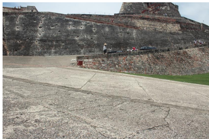
Final de la rampa de acceso 2
