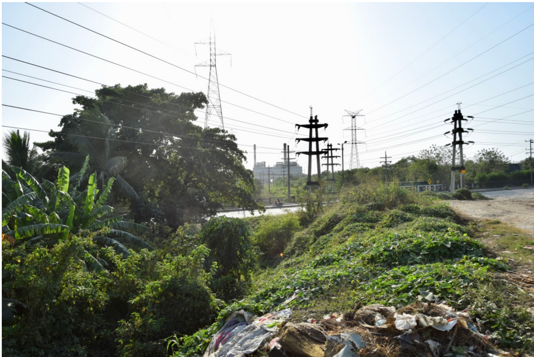
Enfoque desde el lado opuesto mostrando las líneas y la vegetación en la depresión del terreno. El árbol, más alto, viola las normas de seguridad de las redes.
