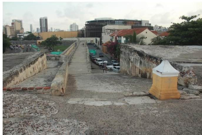
Rampa acceso a cubierta del edificio militar las Bóvedas, y al Baluarte de San Lucas, extremo Norte
