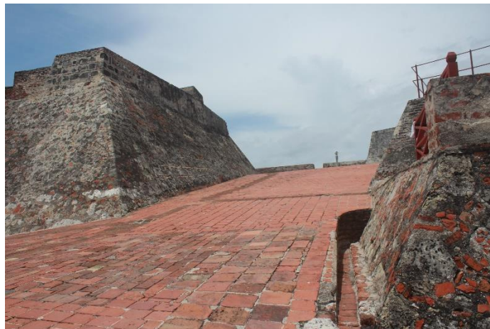
Rampa de acceso 5
