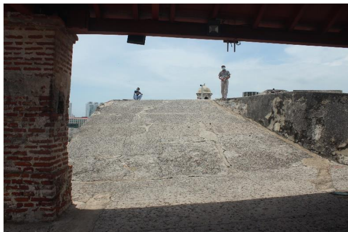
Rampa 11 al costado Norte
