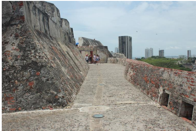
Rampa de acceso 6
