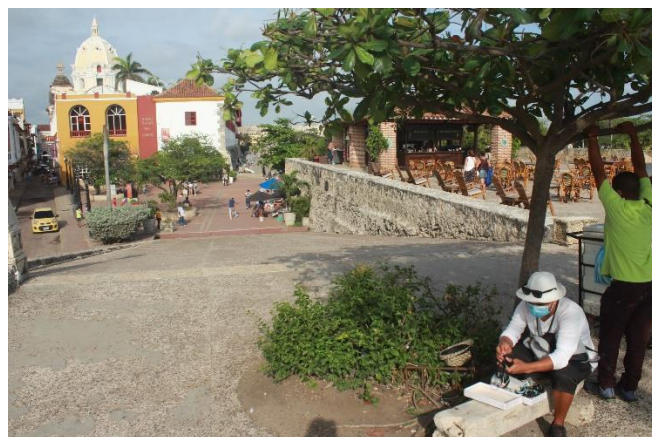
Rampa de acceso al Baluarte de San Francisco Javier
