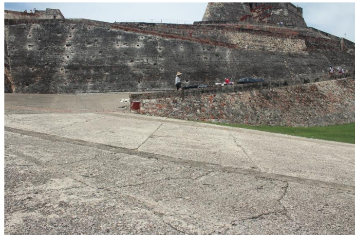
Final de la rampa de acceso 2
