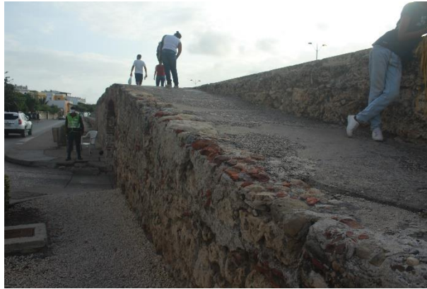
Rampas boca de la Universidad de Cartagena, existen dos, una a cada lado.
