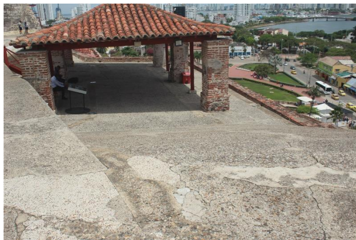
Rampa de bajada al cobertizo 8
