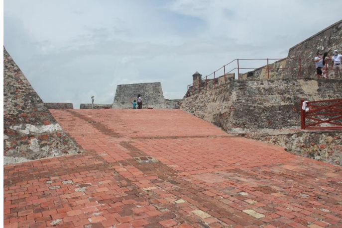
Final de la rampa de acceso 4, e inicio de la rampa 5
