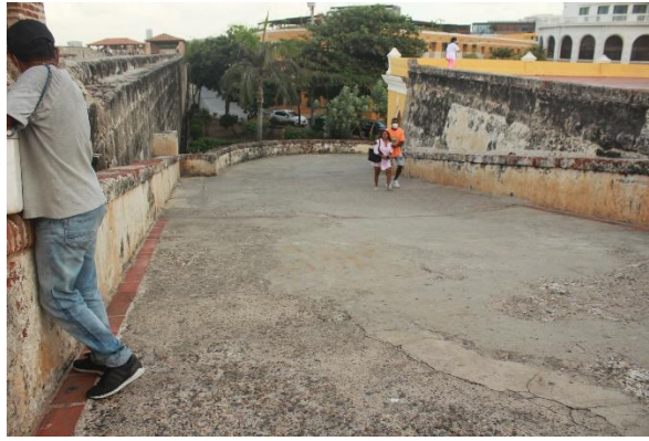
Último tramo de rampa de acceso al edificio militar las bóvedas, también recto
