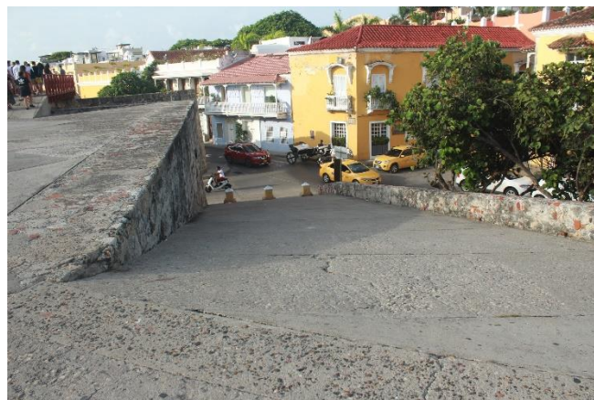
Rampa acceso Baluarte de Santiago Apóstol
