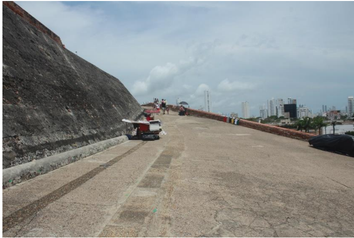
Rampa de acceso 3
