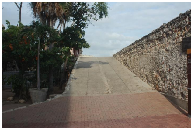
Rampa acceso Baluarte San Ignacio de Loyola
