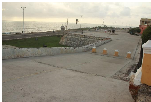
Rampa de acceso a la cubierta plana del edificio militar las Bóvedas, desde el extremo Sur.
