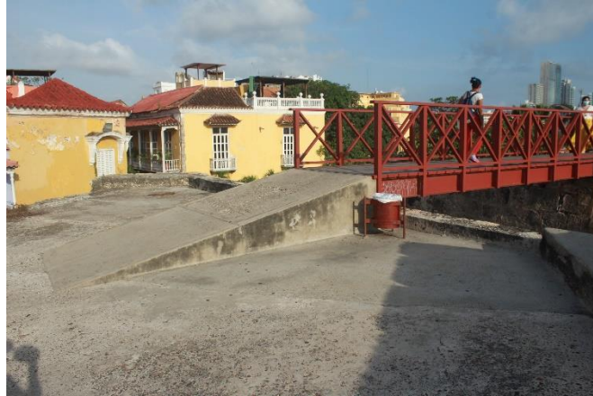
Rampa de acceso al puente que une los Baluartes de Santiago y San Francisco Javier.
