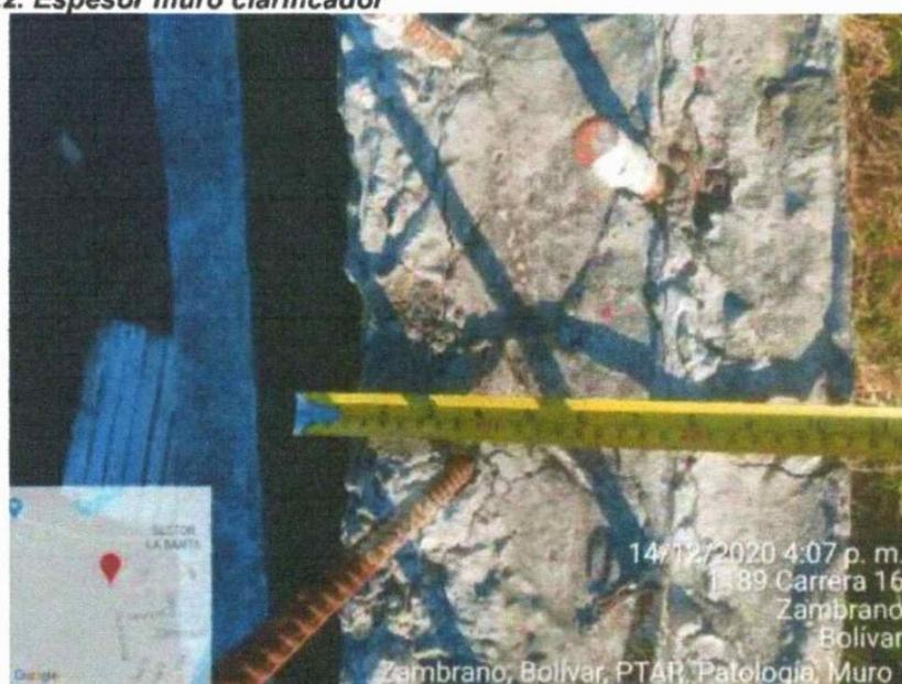
**Figura 23. Determinación recubrimiento.**
