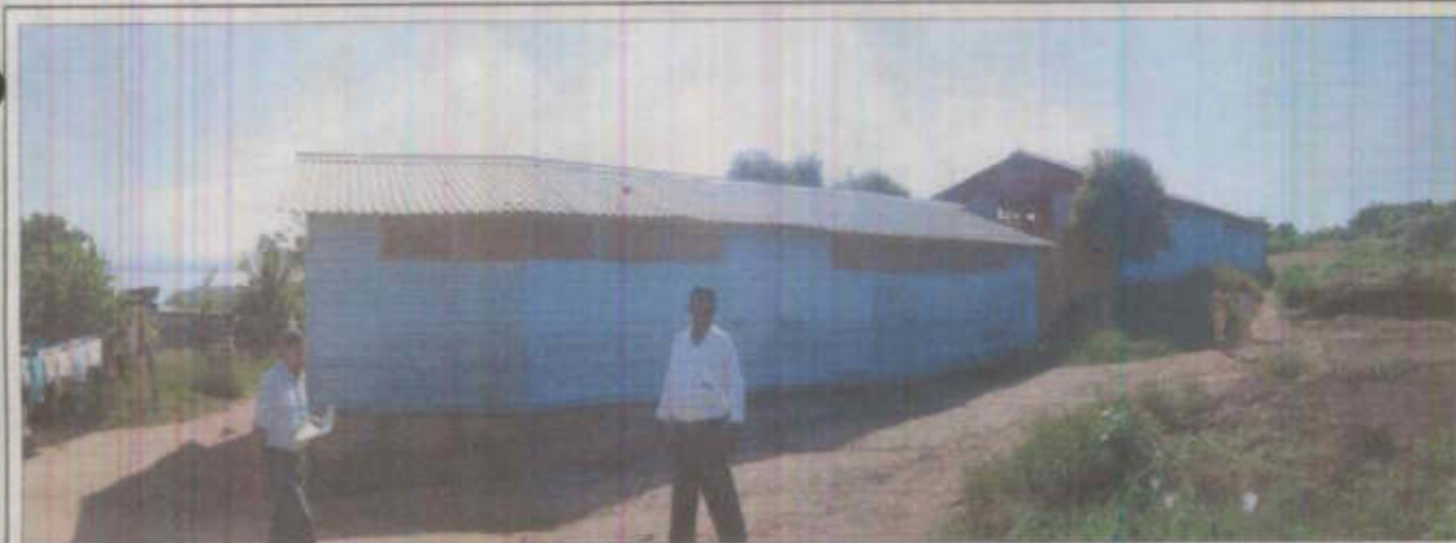
FOTO N° 1 ➤ Visual Tomada desde el extremo Oeste de los terrenos; al frente se muestra la fachada Oeste de la Casa comunal existente en el extremo sur del predio. -
