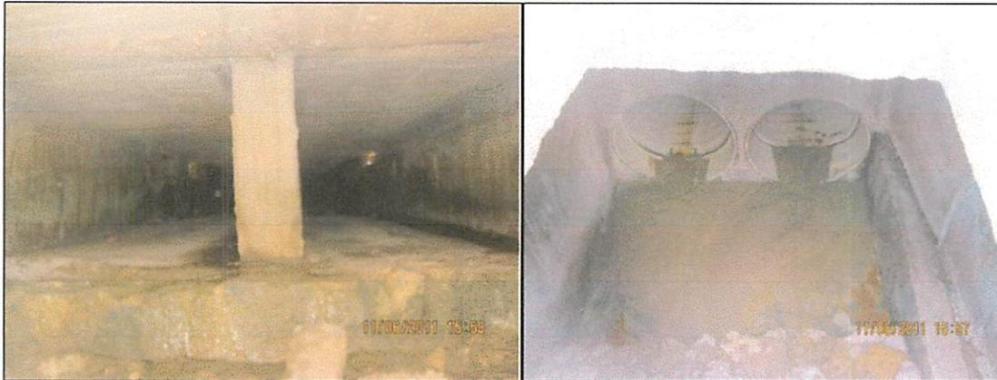
**Figura 6. Canal Parrish sobre la Carrera 41D, tramo rectangular doble en la primera parte del canal y tramo con doble tubería en la parte baja.**
