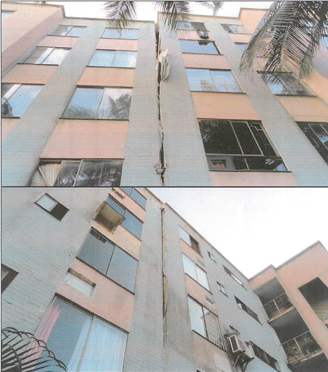
**Figura 24. Separación de bloques.**
