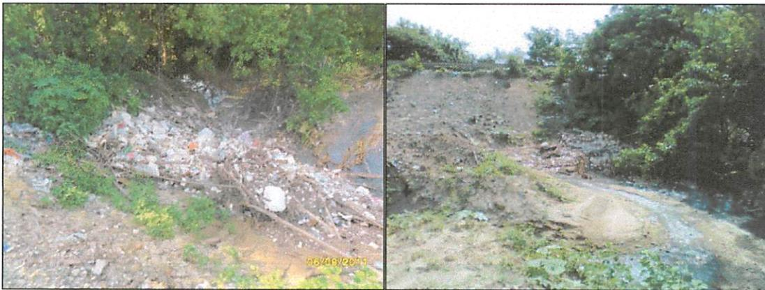
**Figura 8. Llegada del Canal Parrish a la Vía Circunvalar. Se nota la obstrucción que causa el terraplén de la vía. No se evidencia la existencia de estructura hidráulica alguna para dar continuidad al cauce del canal**
