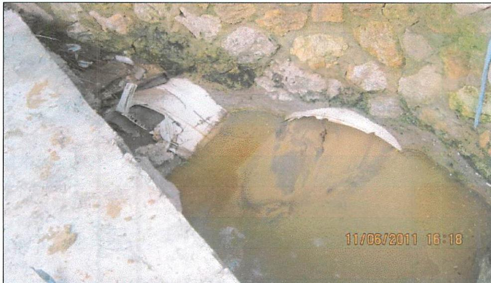
**Figura 7. Desembocadura de las tuberías en el cuerpo del Canal Parrish. Se nota la colmatación por efectos de los sedimentos procedentes de las diferentes obras de ingeniería que se adelantaban en ese momento en la zona.**
