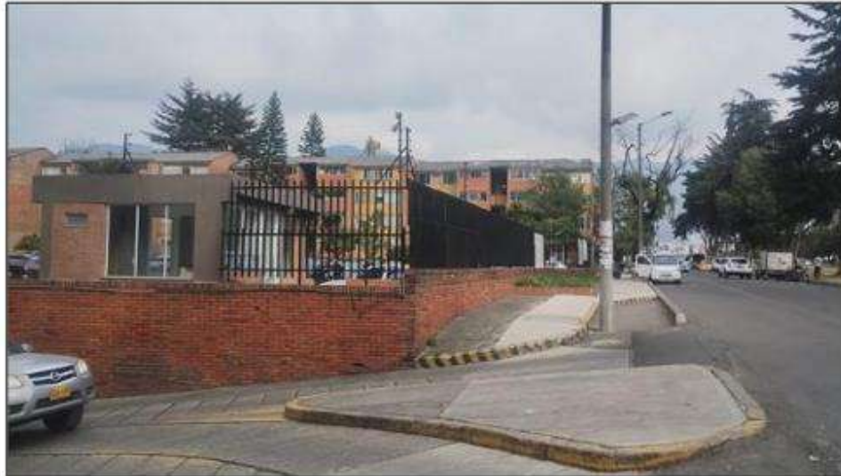
Registro fotográfico N°2 Vista panorámica hacia el oriente de la calle 22 de la Portería #5 construida
