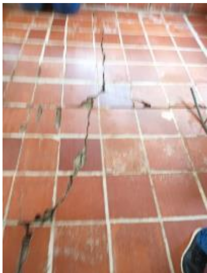
PISO EN KIOSKO
