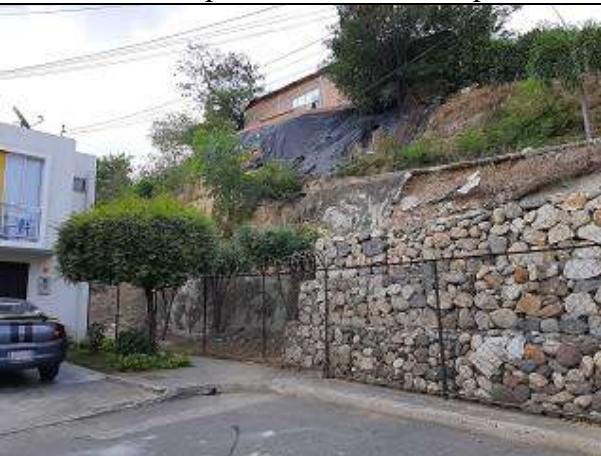
Construcciones próximas al borde superior.
