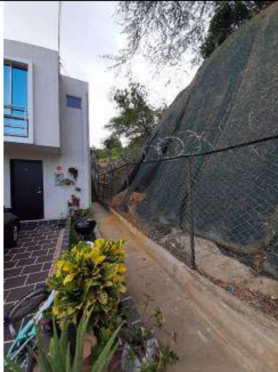
Talud perimetral junto a las viviendas en el costado suroeste del conjunto, zona posterior.
