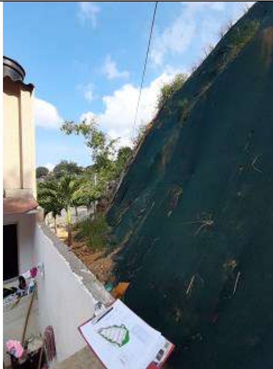
Talud perimetral junto a las viviendas en el costado sureste del conjunto, zona posterior.
