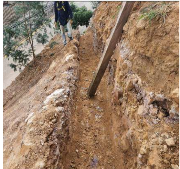
Trabajos de construcción de drenajes.
