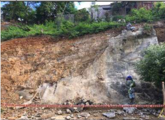
Trabajos de demolición de recubrimientos.
