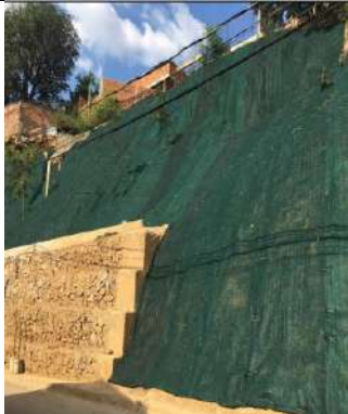
Trabajos de instalación de geosintético TRM500.
