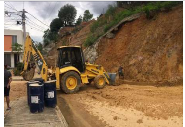
Trabajos de remoción de escombros.
