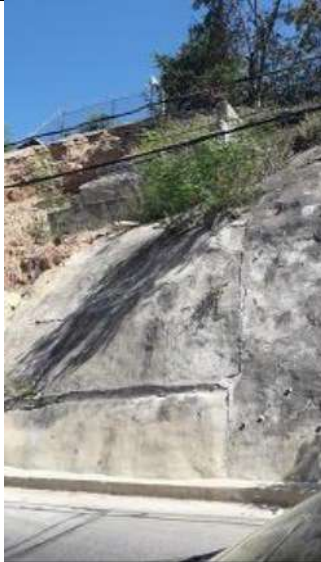
Trabajos de recubrimiento con concreto.
