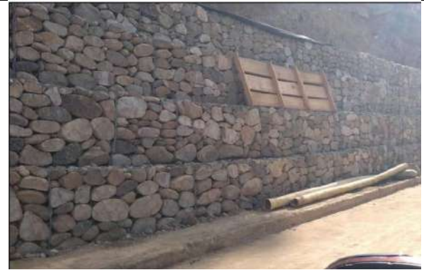
Trabajo de construcción de gaviones.
