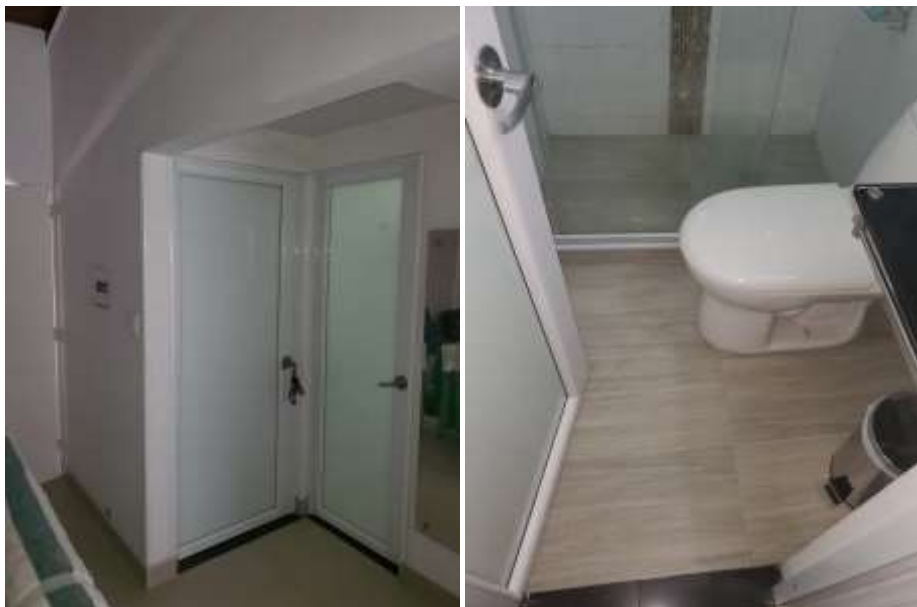
PUERTANS CON MARCO EN ALUMINIO Y VIDRIOS BAÑO CON PISOS Y MUROS ENCHAPADOS EN CERÁMICA
