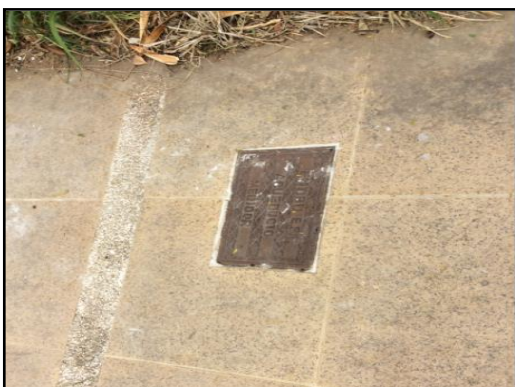
Medidor de agua
