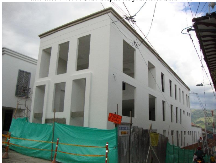
Ilustración No. 7: Sede despachos judiciales Salamina
