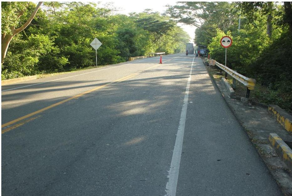
**IMG\_3646.JPG**, la imagen ilustra las características de la vía Palomino Riohacha a la altura del km 52+900, trata de una calzada, dos carriles de circulación vehicular, material asfalto, señales horizontales indicando para el carril sentido de circulación vehicular origen Riohacha con destino a Palomino se evidencia línea central de color amarilla segmentada y
