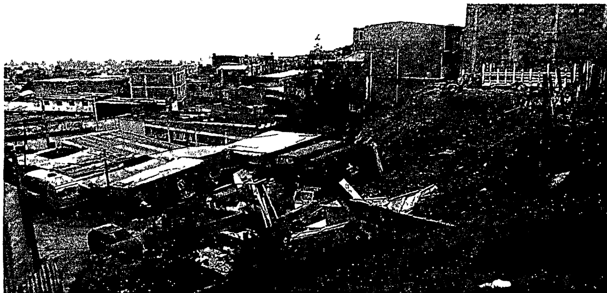
PANORAMICA, POSTAL DE TODO EL BIEN INMUEBLE, TOMADA SENTIDO SUR AL NORTE
