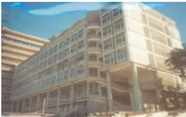
Rehabilitación Despachos Judiciales de Barranquilla.
