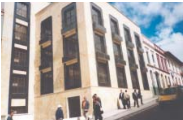
Construcción II Etapa Palacio de Justicia de Tunja.
