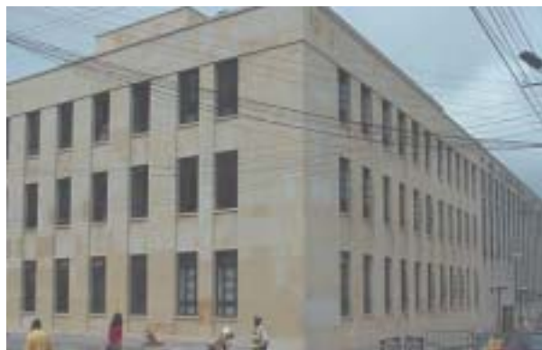
Construcción II Etapa Palacio de Justicia Bucaramanga - Santander.
