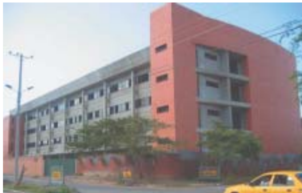
Construcción II Etapa Palacio de Justicia de Cúcuta - N. de Santander.
